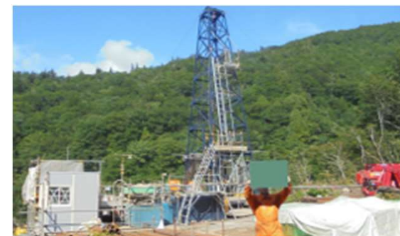
地質調査の様子(JR東日本提供)
